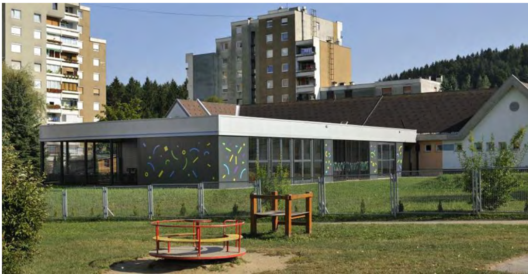
Figura 17. Perspectiva ampliación y estructura antigua
