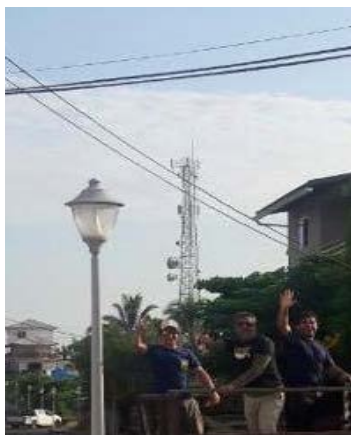
Figura 32. Fotografía panorámica de la Torre Auto soportada PUERTO VILLAMIL
