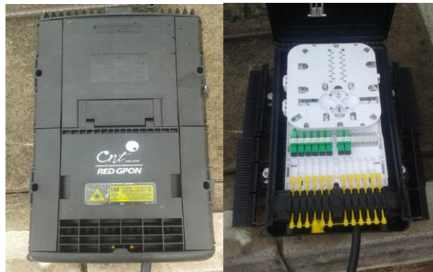
Figura 33. Caja de distribución NAP. Adaptado de (CNT E.P., s.f.)
