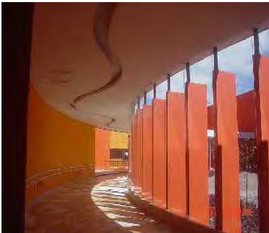
Fotografía 13 Vista Corredor Exterior.
