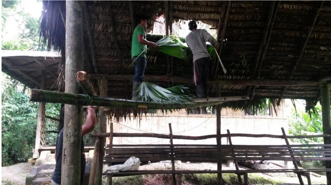
Figura 37. Reconstrucción de techo en el Centro de interpretación
