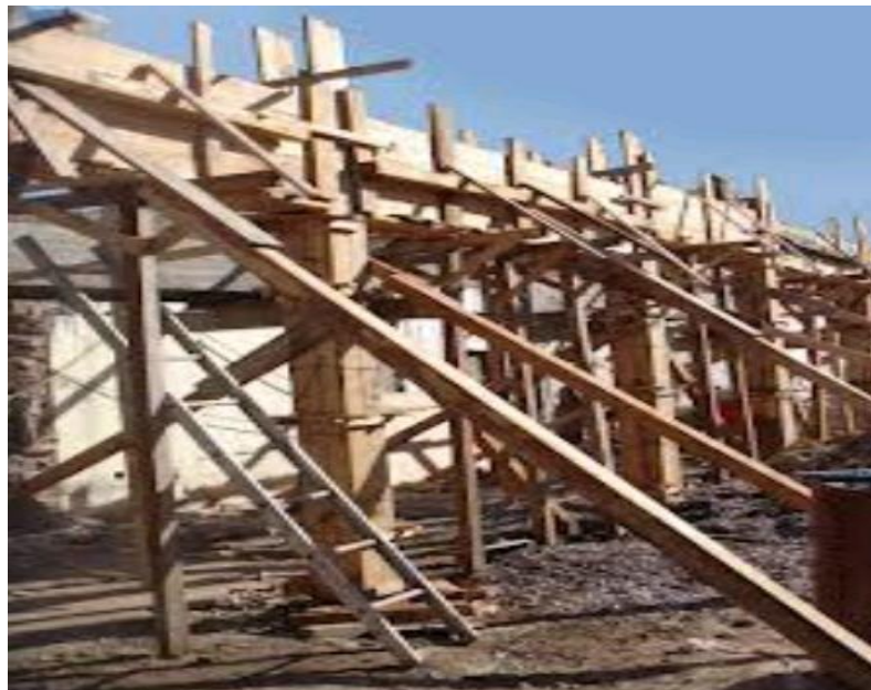
Figura 19 Puntales y encofrado de madera Tomado: (ALLBIZ, 2015)
