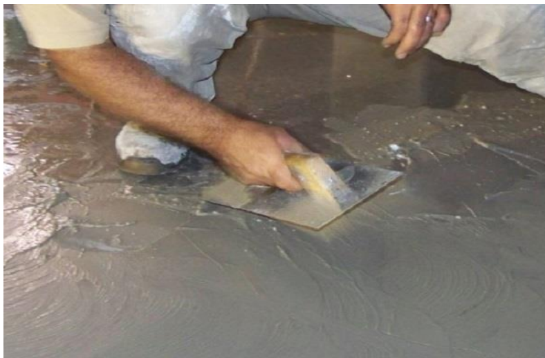
Figura 26 Amasado con paleta metálica para un piso pulido Tomado: (Espada, 2014)
