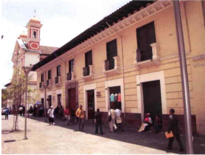
Casa Neptalí Bonifaz, fachada noreste
