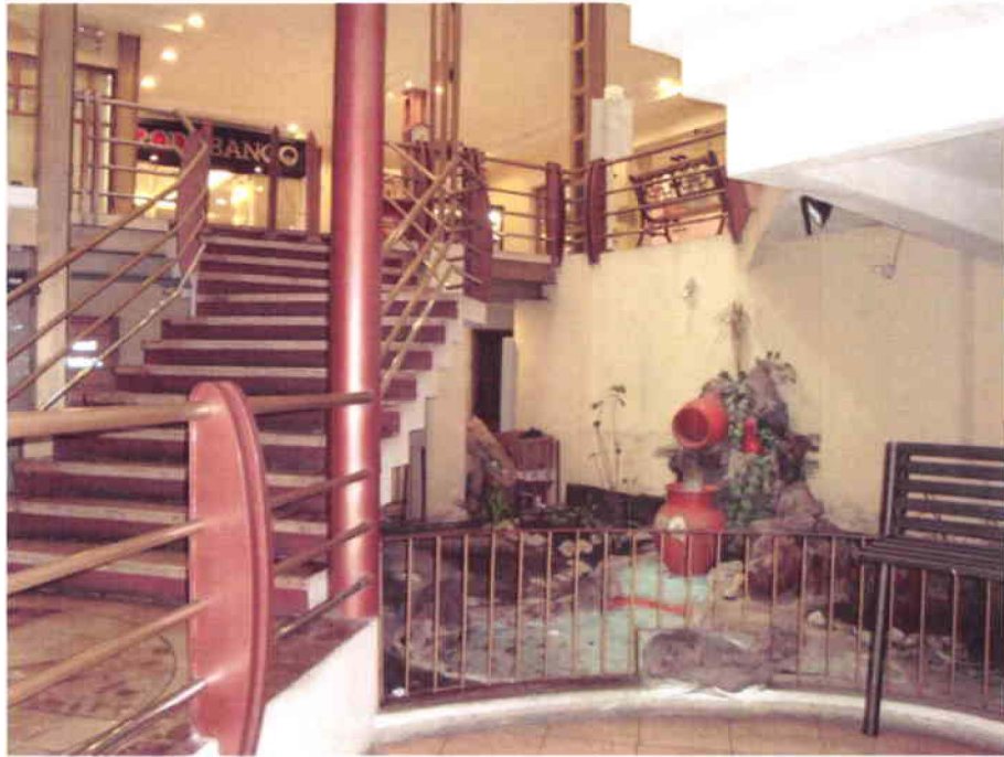
Situación Actual – Subsuelo CCE
