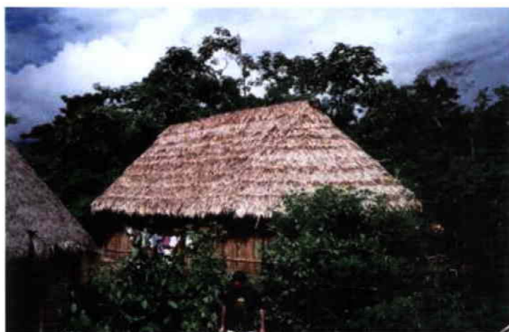
Estructura de Cubierta con Palma de Canambo
