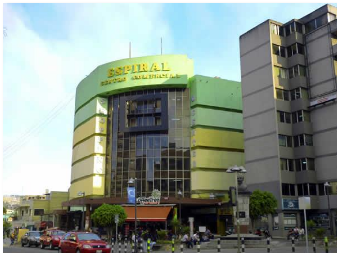
Figura 32. Entrada al Centro Comercial Espiral.
