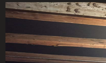
VIGAS DE MADERA
