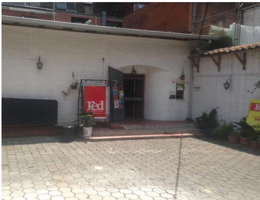
Figura 37. Boletería e ingreso al Teatro.
