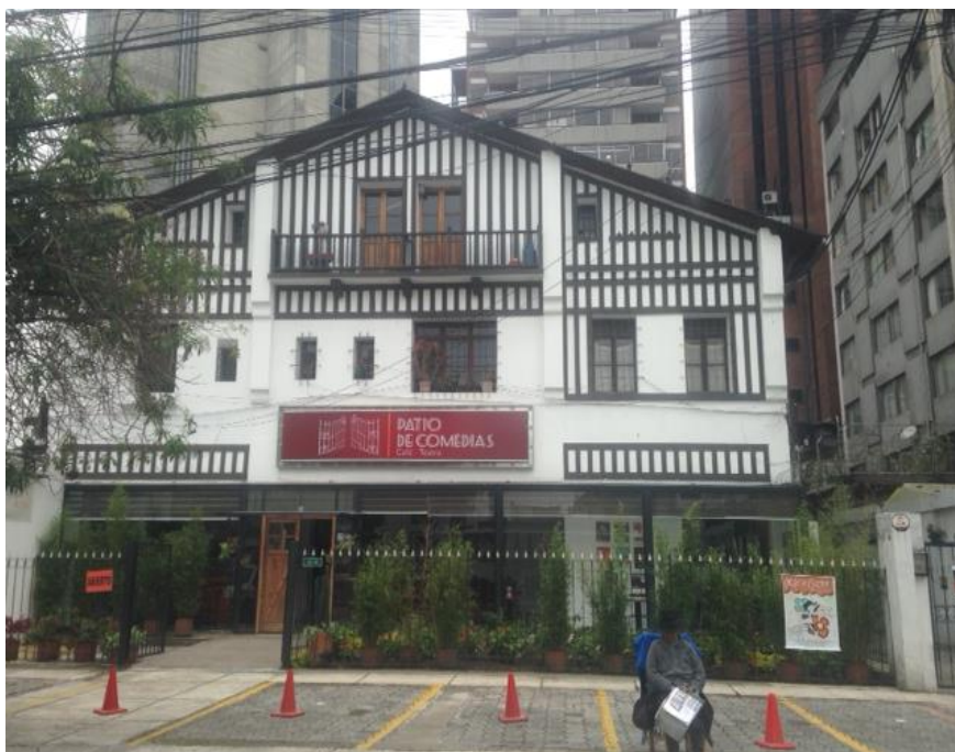
Figura 36. Fachada frontal de la Edificación.
