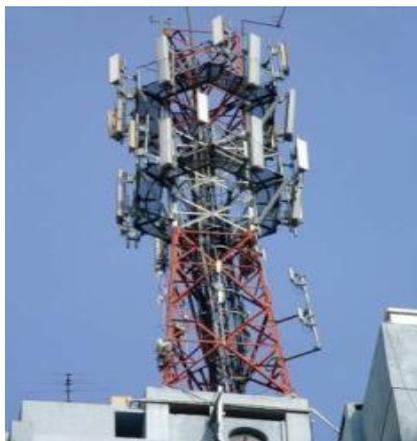
Figura 15. Antena Sectorial para LTE
