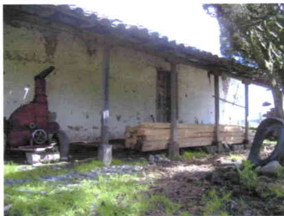
Establo y Bodegas de Almacenamiento
