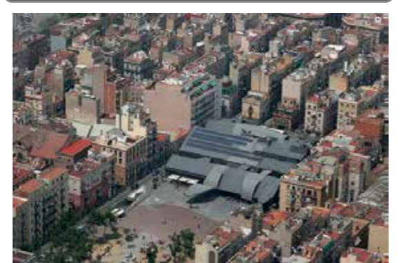
Figura 89: Vista Exterior Tomado de: (Plataformaarquitectura, 2011)
