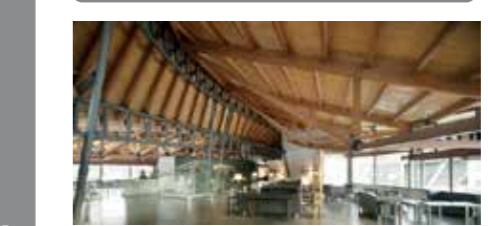
Figura 99: Estructura en Obra Tomado de: (Plataformaarquitectura, 2011)
