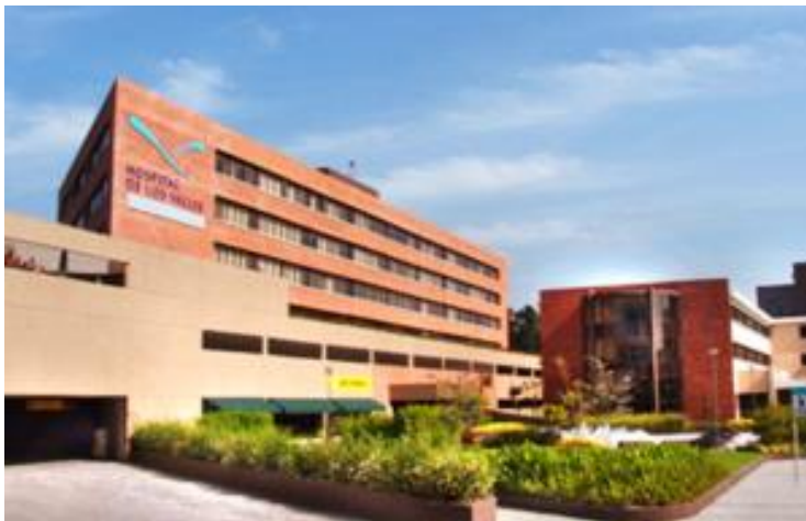
Figura 29. Plaza exterior Hospital de los valles
