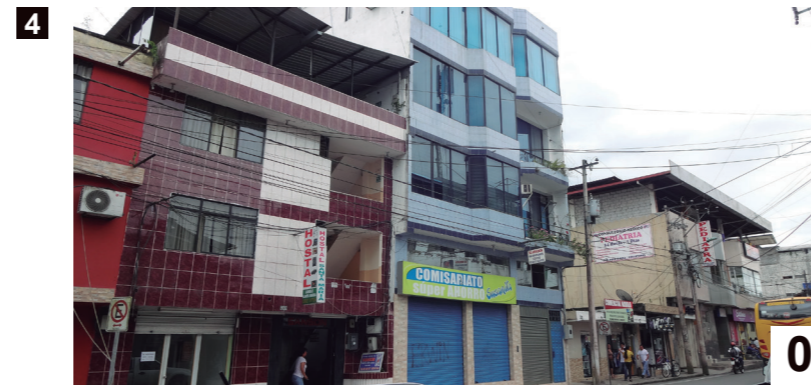
Figura 147. Visual hacia la calle Vicente Rocafuerte
