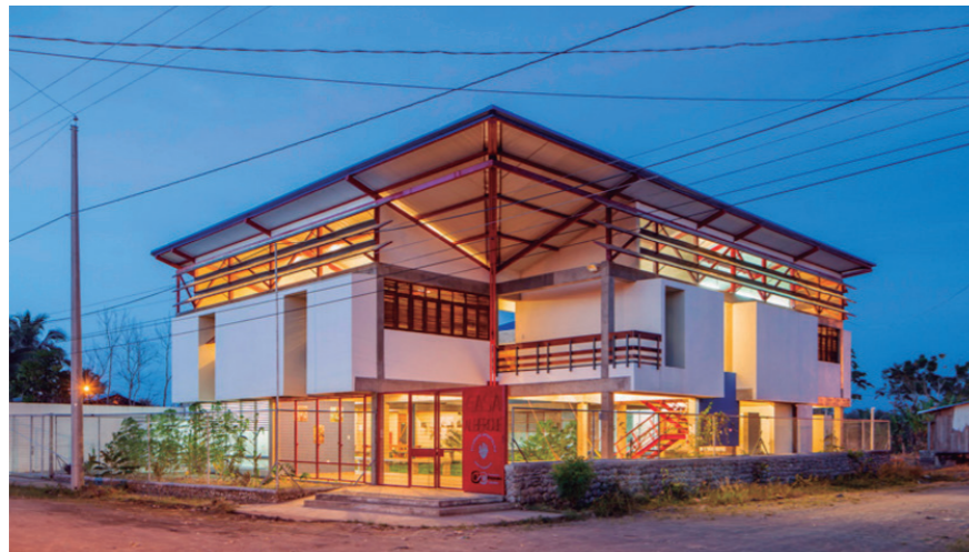
Figura 56. Vista del acceso principal de la Casa Albergue Tomado de (Redfundamentos, s.f.)
