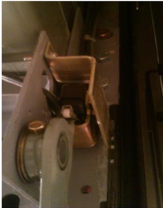
**Dispositivo de seguridad Safety bajo cabina del ascensor**
