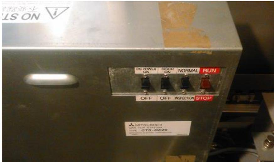
**Dispositivo de seguridad switch de RUN – STOP sobre cabina**
