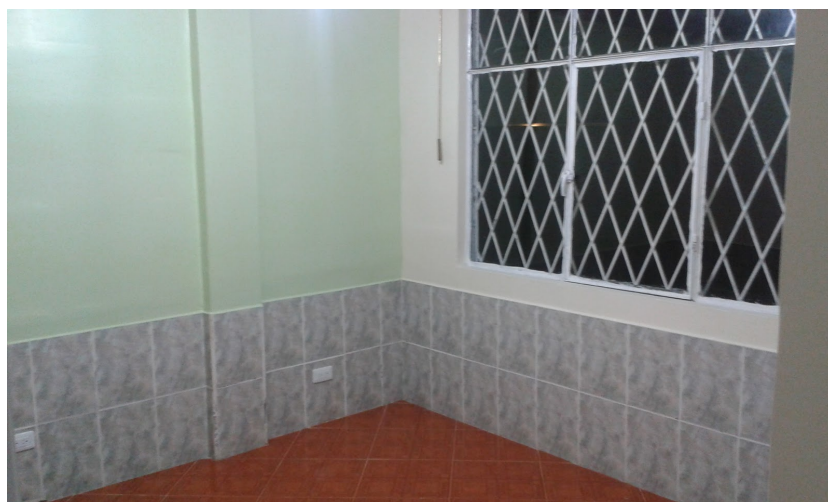
Figura 23. Foto real de Control Room .
