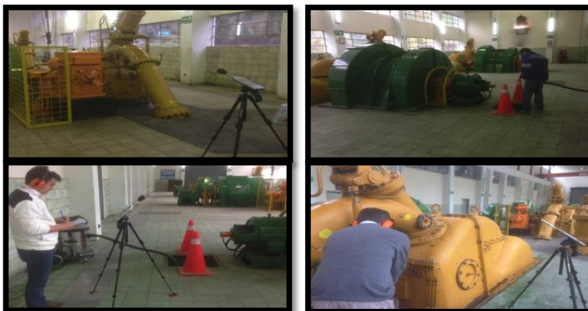
Figura 10. Puntos de medición sala de máquinas
