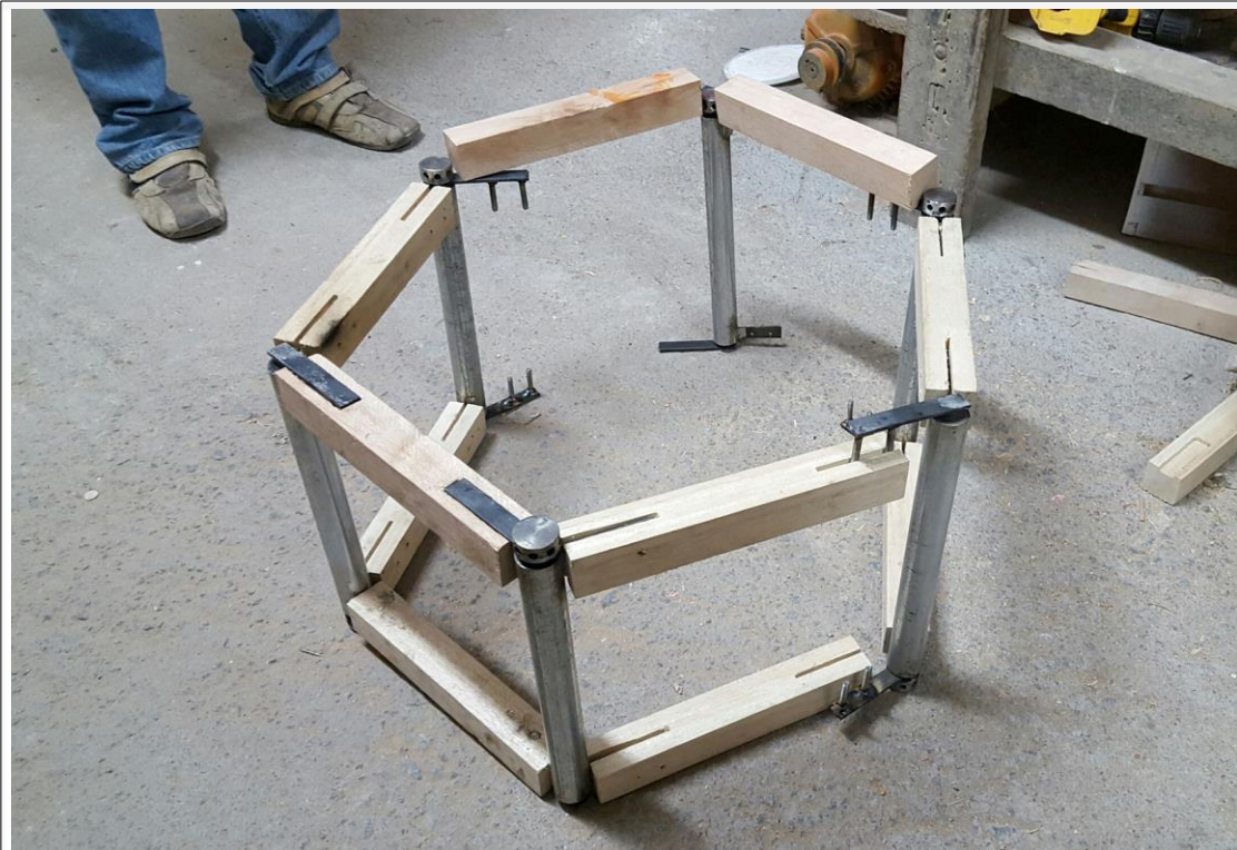
Figura 67. Estructura completa hexagonal (sin acabados).
