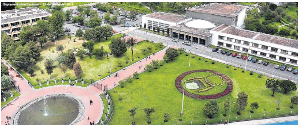
Figura 3. Imagen de la Universidad Central en su arquitectura original. Tomado de: http://www.uce.edu.ec .
