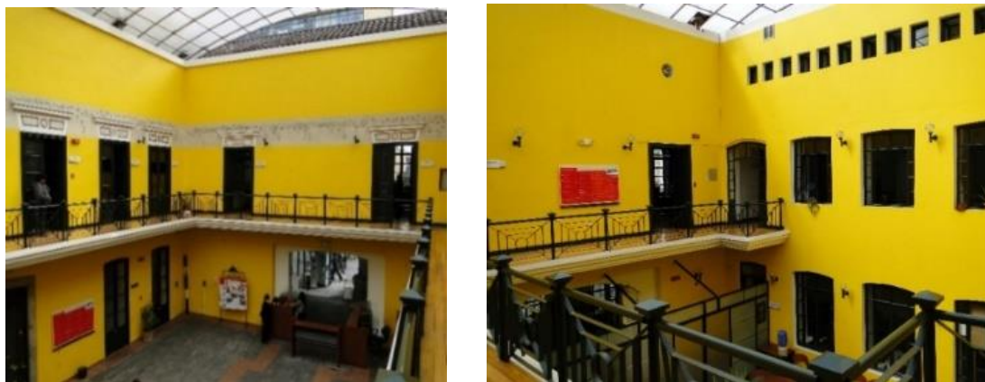
Figura 40. Pintura mural en el patio norte y patio sur de la edificación actual.
