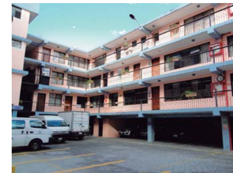
Edificio 2, ubicado en la parte posterior del edificio Patrimonial
