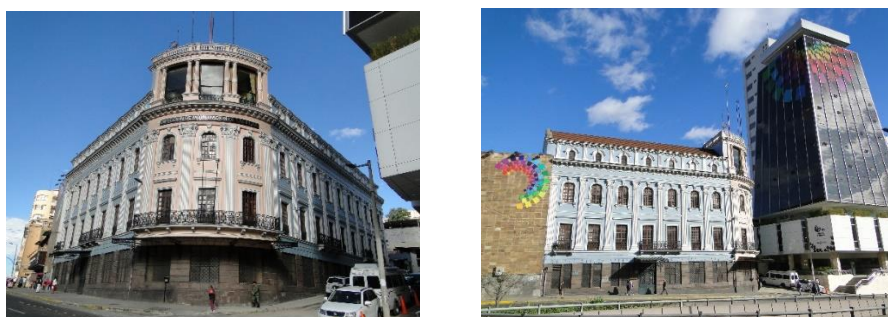
Figura 62. Edificio de la Dirección de Movilización de las F.F.A.A.
