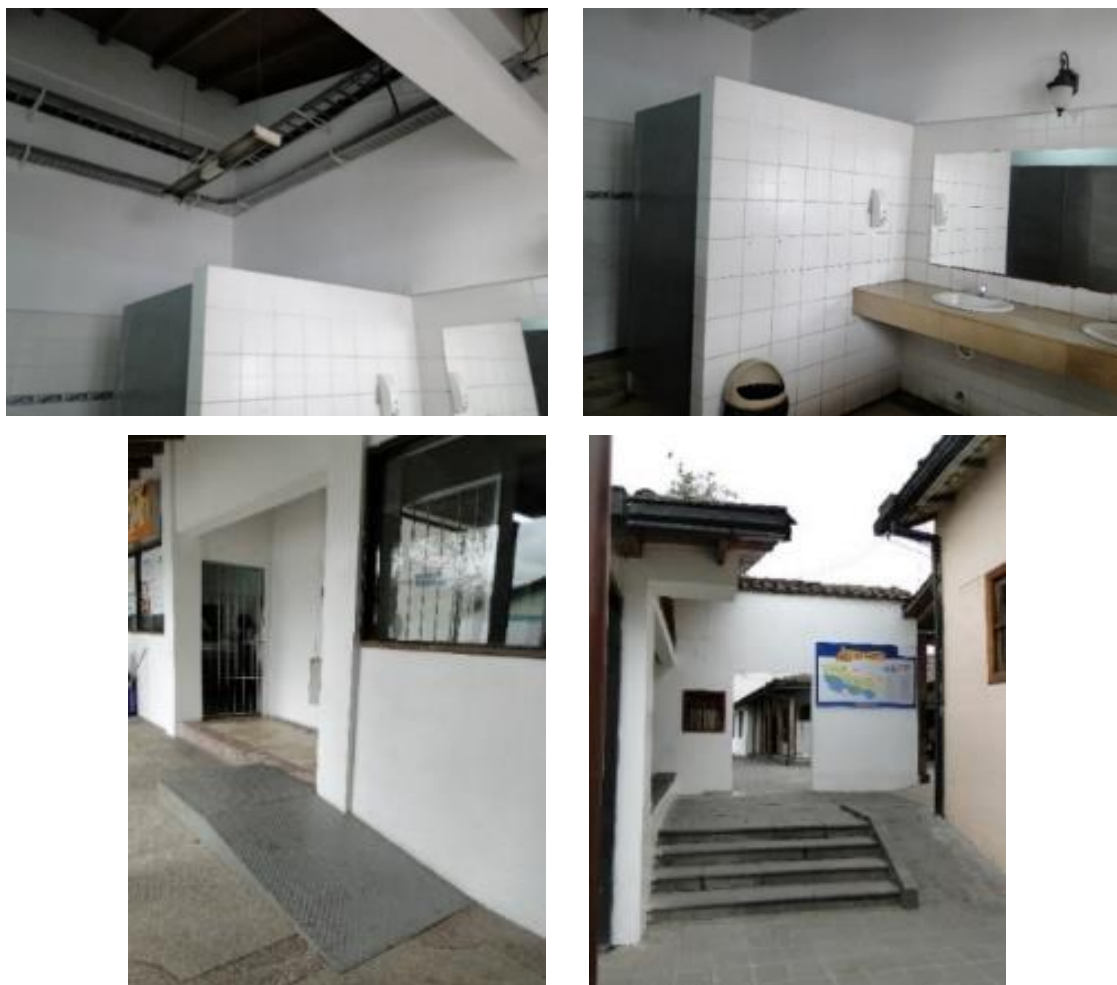
Figura 51. Interior del baño y rampas.
