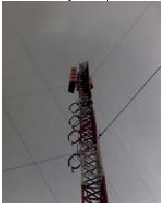
Gráfico 3.6 Sistemas Radiantes FM Paneles y diedros para Televisión
