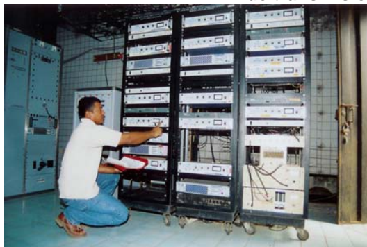
Gráfico 3.7 Instalación de sistemas de transmisión
