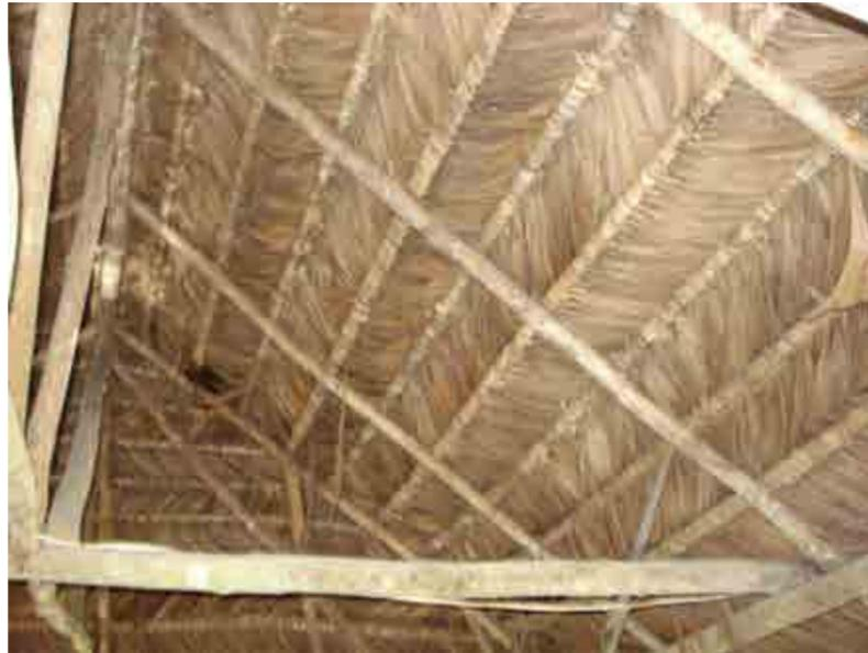
Figura 54. Cubierta de una vivienda amazónica. Amarres y cubierta de hojas.
