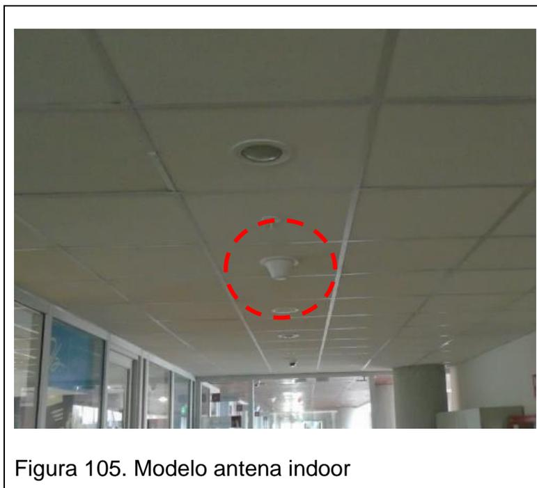
Figura 105. Modelo antena indoor
