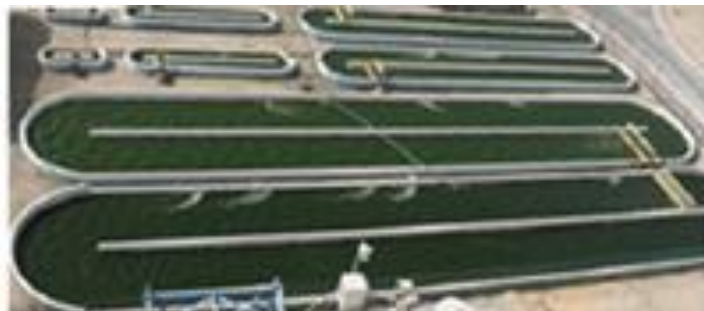
Figura 3. Sistema abierto: biorreactor conocido como biorreactor de tipo carrusel usado para el cultivo intensivo de microalgas.
