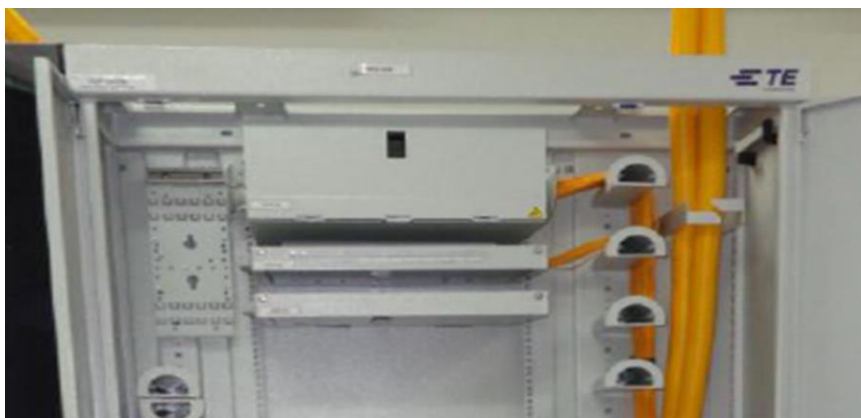
Figura 25. Distribuidor de fibra óptica Tomado de (CNT E.P., 2015, pág. 53)
