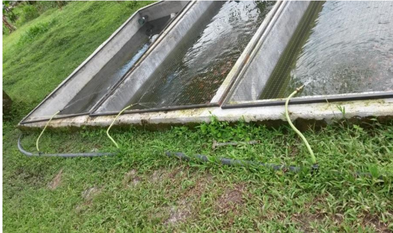
Figura 15. Foto mangueras de abastecimiento de agua para estanques.
