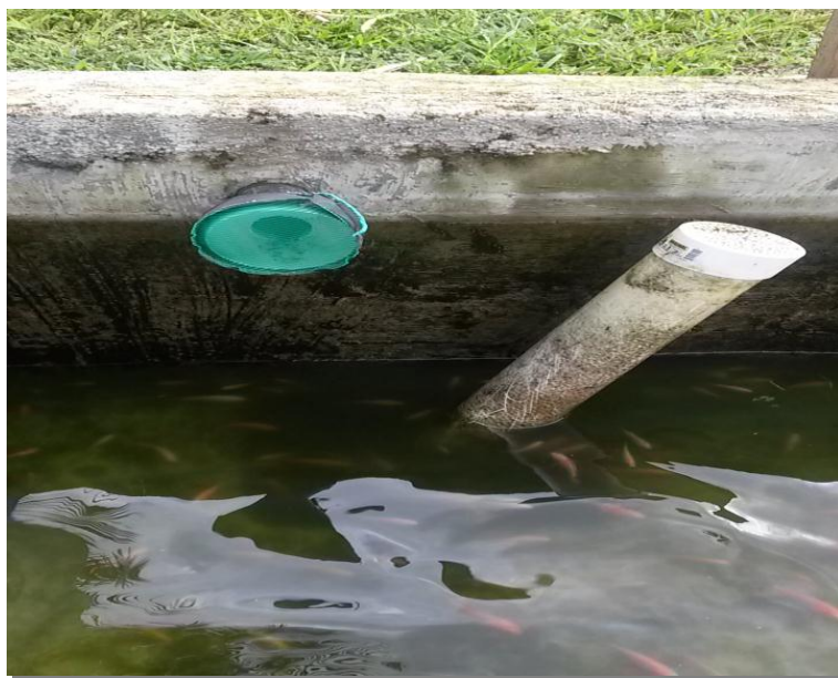
Figura 16. Foto Desagües para desfogue y recambio de agua
