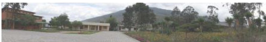
Figura 55. Fotografía panorámica del interior del establecimiento..
