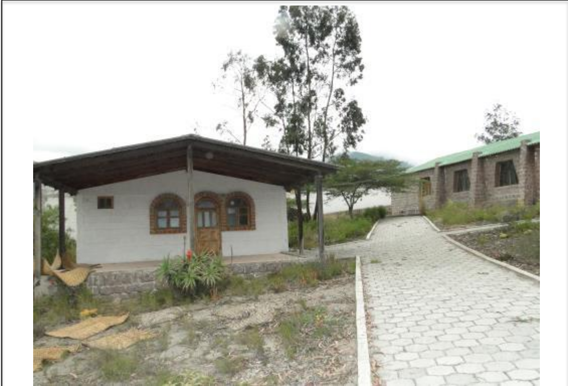
Figura 109. Fotografía del estado actual exterior bloque 5 y bloque 6.
