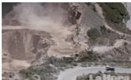
Figura 61. Fotografía área de una de las 19 canteras de San Antonio de Pichincha, Tomado de (La Hora, s.f.)
