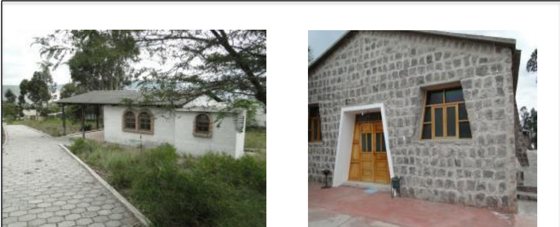
Figura 110. Fotografías del estado actual exterior de bloque 5 y 6 respectivamente.
