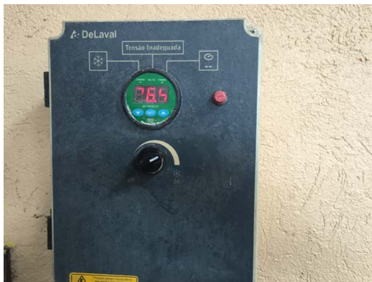
Figura 3. Medidor de temperatura del tanque de enfriamiento de leche en el centro de acopio de La Chimba.
