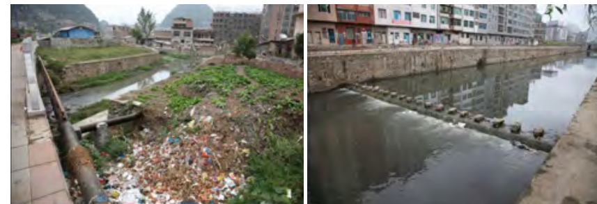
Figura 120. Minghu Wetland Park, Historia. Tomado de (Minghu, s.f.) a) Contaminación. b) Canal de agua.
