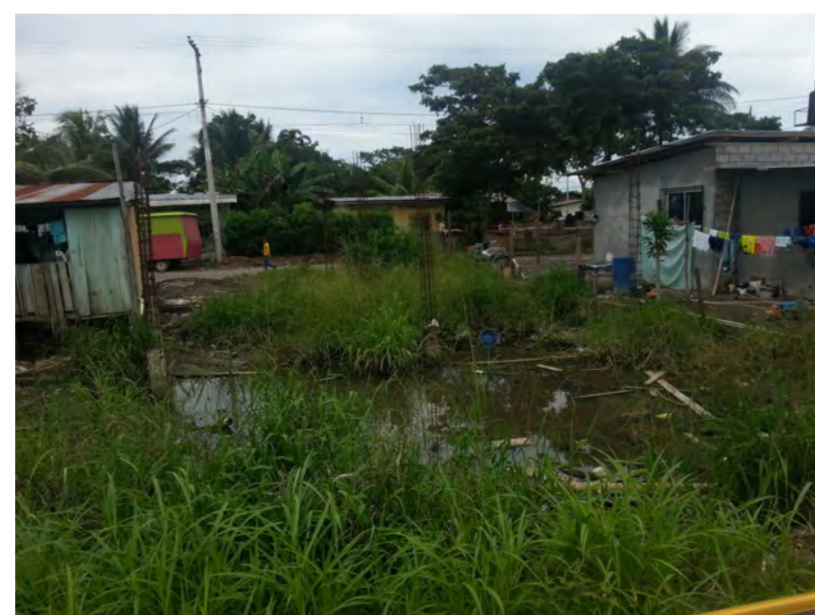
Presencia de agua en las edificaciones. Fuente: UDLA ARO-960
