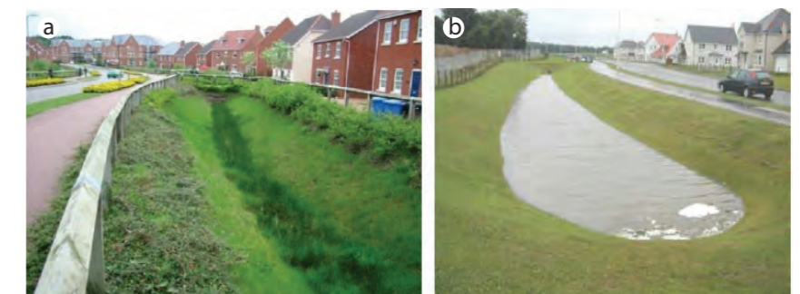
Figura 75. Canales / Cunetas Verdes. Tomado de (Paisaje sustentable, 2012) a) Canales b) Cunetas Verdes
