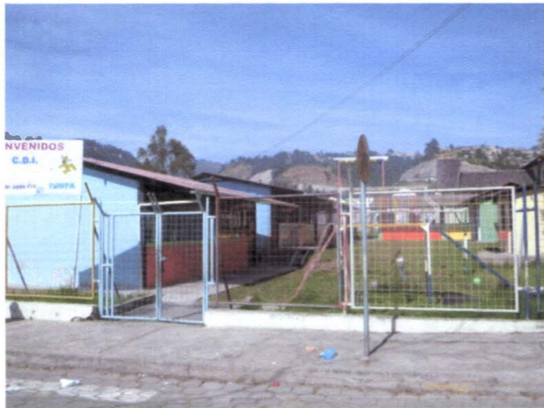
Fotografía 2.7 Casas en mal estado
