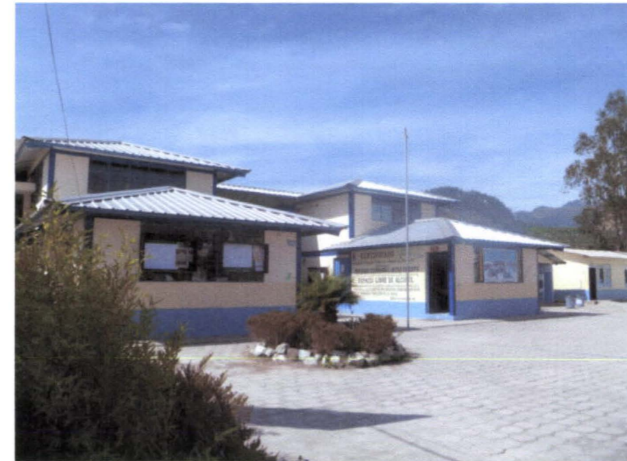
Fotografía 2.8 Casas en mal estado
