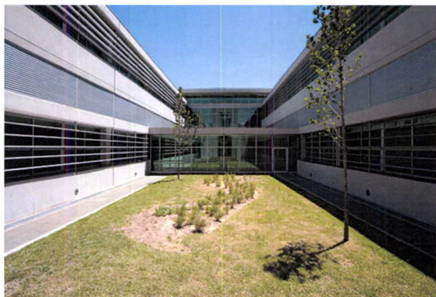
Imagen No.11. Espacio Público-Privado Hospital de Emergencias Clemente Álvarez de Argentina.
