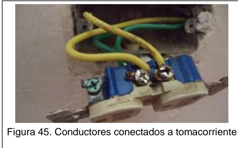
Figura 45. Conductores conectados a tomacorriente
