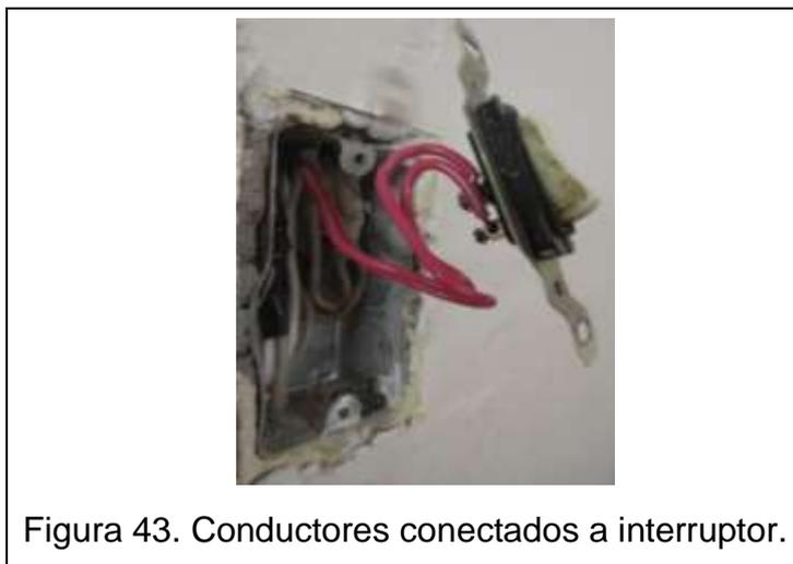
Figura 43. Conductores conectados a interruptor.
