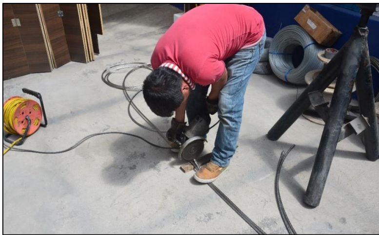
Figura 43. Actividad de corte de cables de acero.
