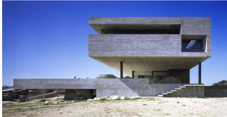
Figura 59: Acabado de pared en hormigón visto.
