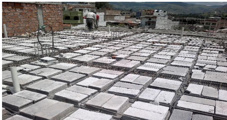
Figura 56: Colocación de hierro y bloque.
