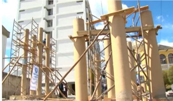
Figura 41: Apuntalamiento de las columnas redondas.
