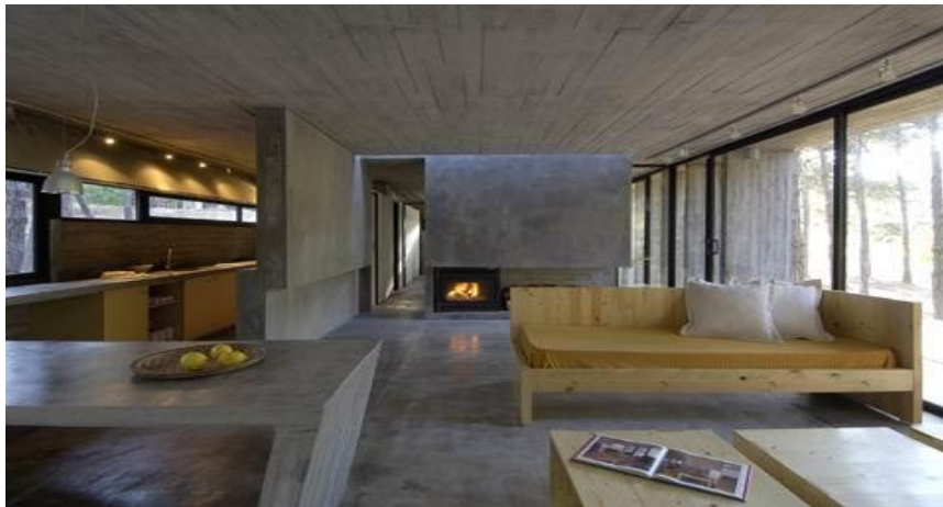
Figura 63: Techo de hormigón visto realizado con encofrado reciclado.
