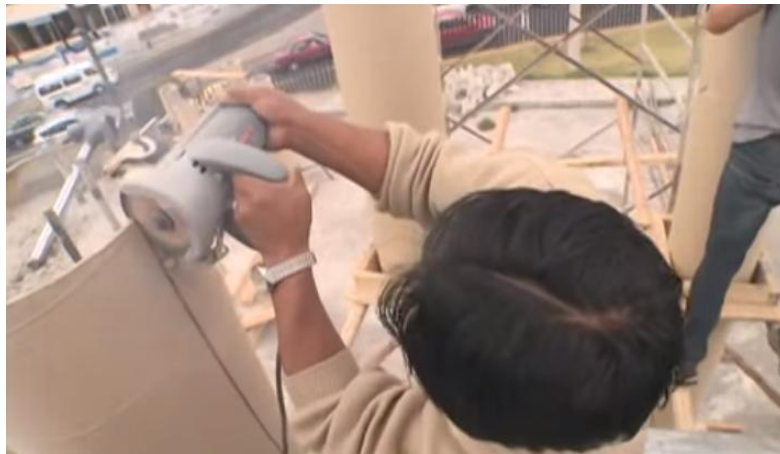
Figura 43: Desencofrado corte del encofrado de cartón.
