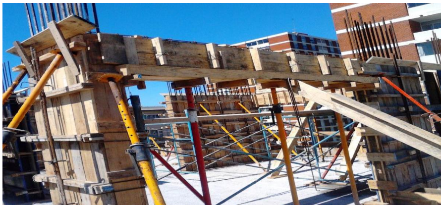
Figura 50: Colocación de gatas, separadores y crucetas.
