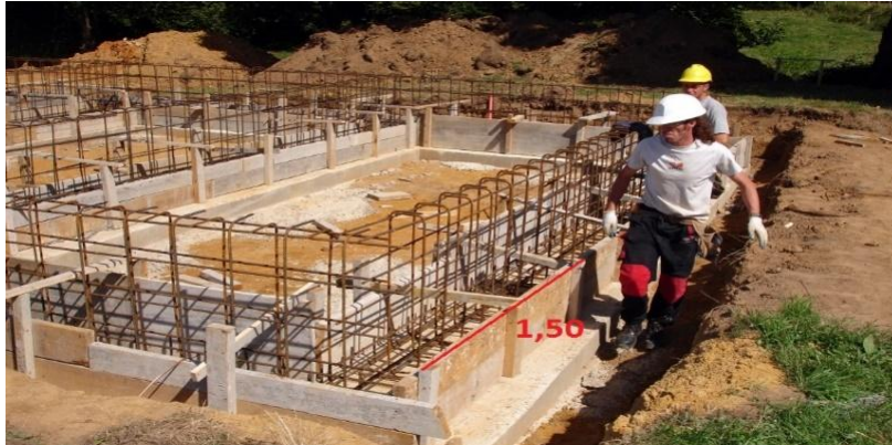
Figura 32: Tablero encofrado en cimentación.
