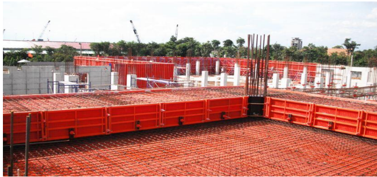
Figura 5: Encofrado de Plástico.
