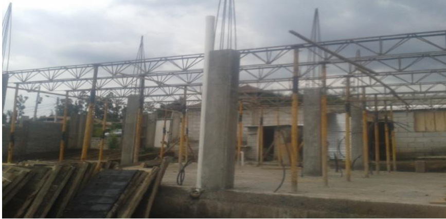
Figura 51: Colocación de vigas.
