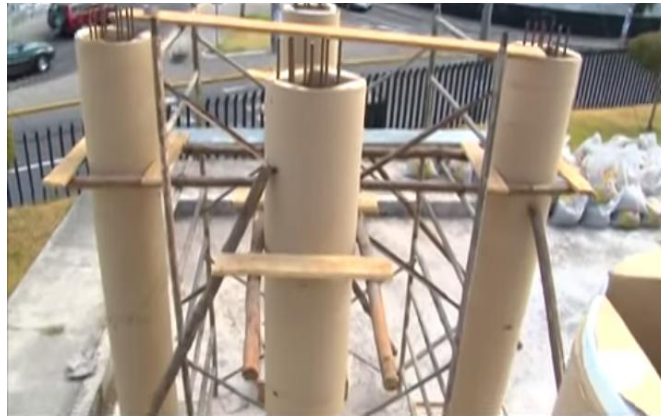
Figura 40 : Apuntalamiento de las columnas.
