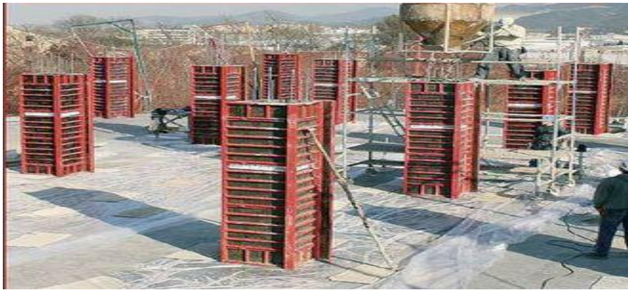
Figura 3: Encofrado Vertical
