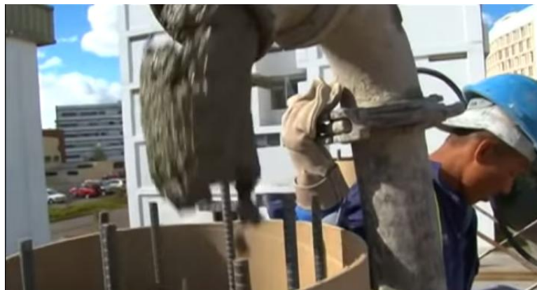
Figura 42: Hormigonado de columnas.
