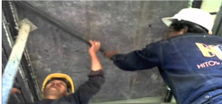
Figura 58: Desencofrado de losa.
