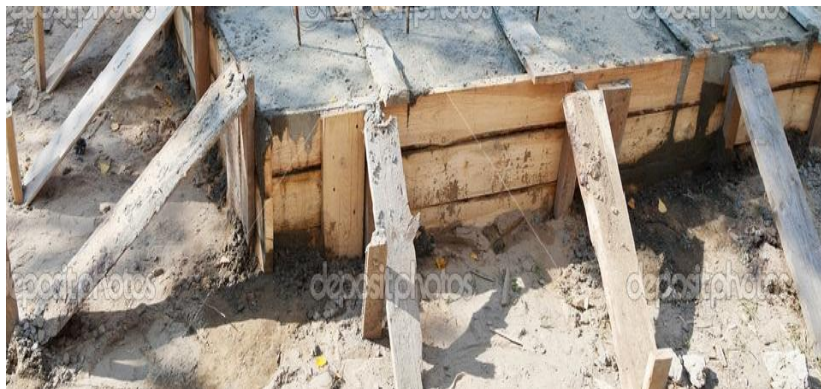
Figura 33: Cuñas de refuerzo para el tablero reciclado.
