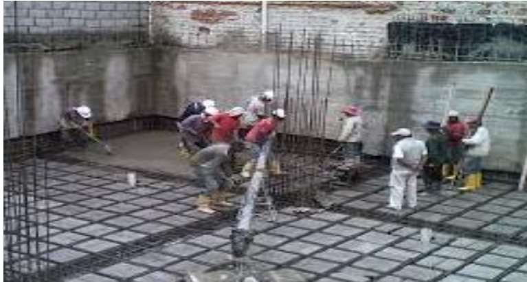
Figura 57: Hormigonado de losa.
