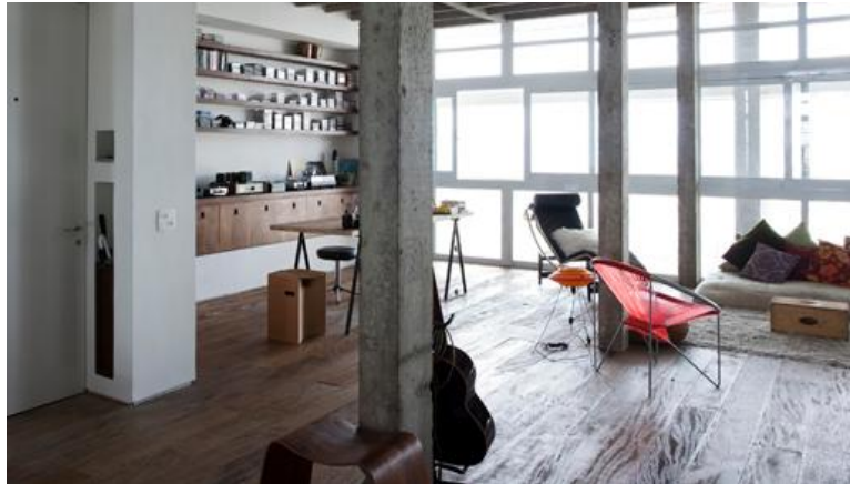
Figura 62: Columnas realizadas con columna Fácil cuadrada.
