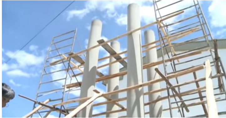
Figura 61: Columnas realizadas con columna Fácil.
