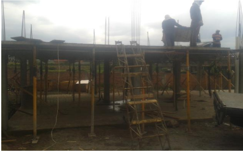
Figura 53: Colocación del tablero reciclado de madera.
