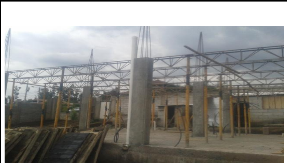
Figura 4: Encofrado horizontal.
