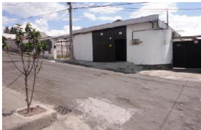
Figura 36. Fotografía exterior de la bodega.
