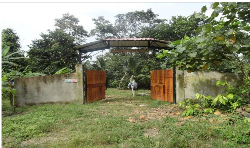
Figura No 22. Entrada remodelada de la hacienda.
