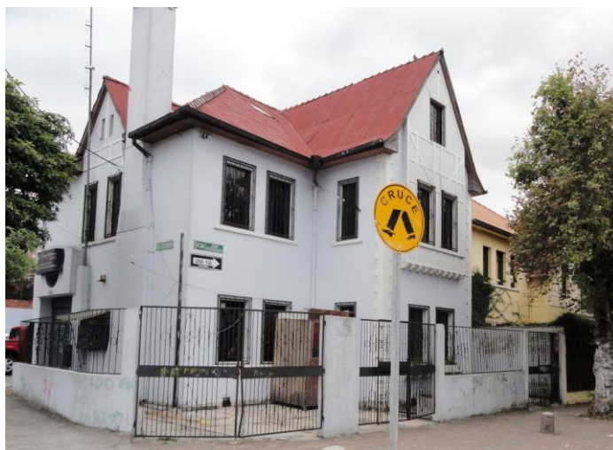
Figura 3. Foto lateral del local para la operación de la planta de deshidratación de tisanas tomado de: (Loaiza, 2011)
