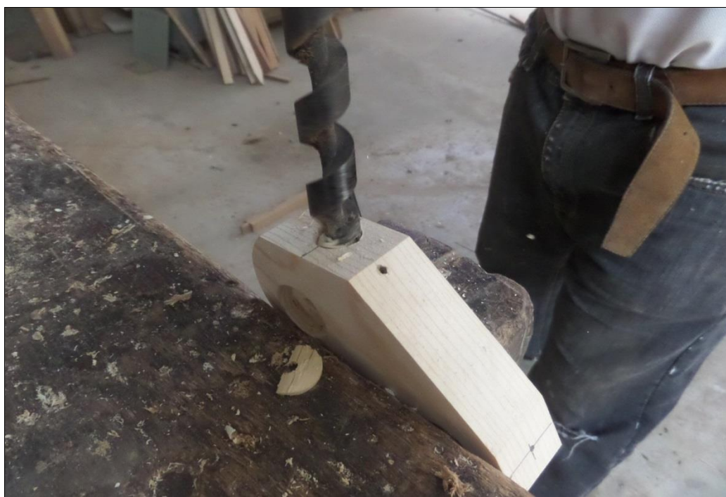
Figura 144 y 145. Paso 8: Se trazan las mitades en el espesor para incrustar los imanes de la cabeza y la cola. Este paso es más complejo por la falta de agarre que se puede tener de la pieza, por lo que se utiliza una prensa que sujete firmemente la pieza.
