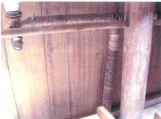
A06 Detalle de tuberías en bejuco
