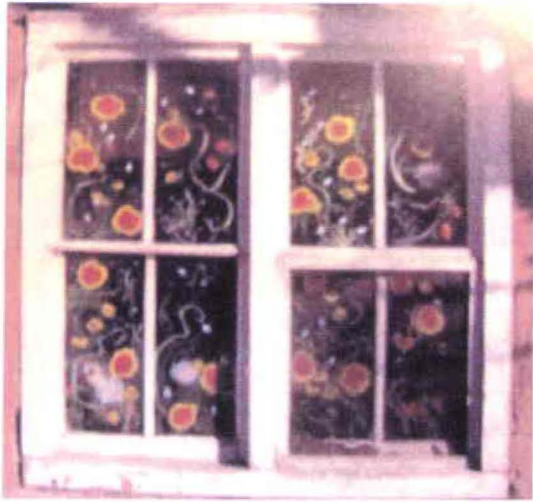
A17 Detalle de pintura ventanas de mampara
