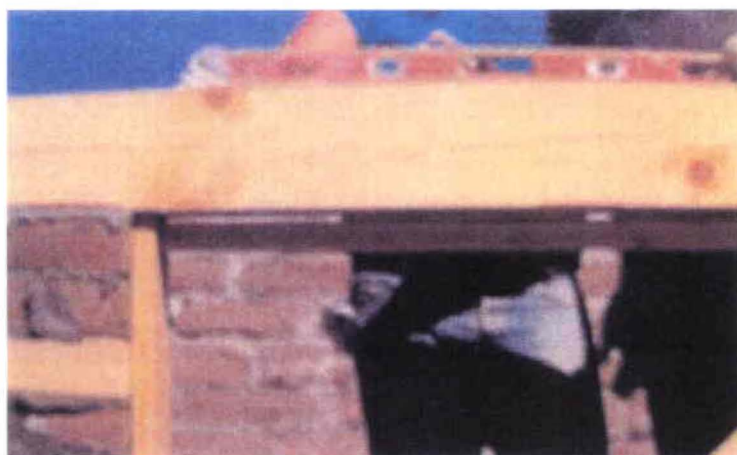
DC21 Colocación de dintel
