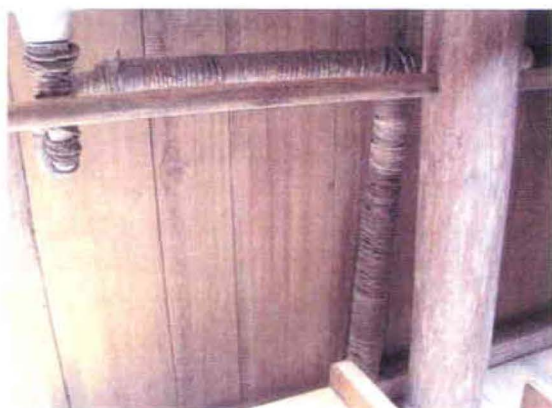
A06 Detalle de tuberías en bejuco
