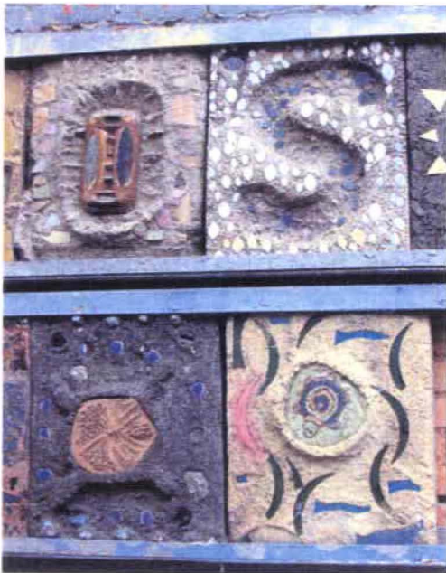
A06 Detalle de cerámica en pared de patio interior
