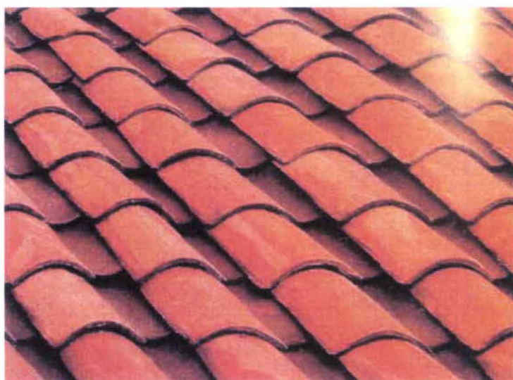
DC12 Cubierta de teja
