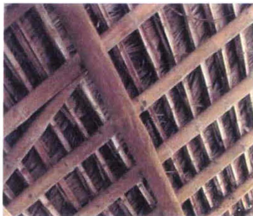
DC9 Detalle interno de cubierta
