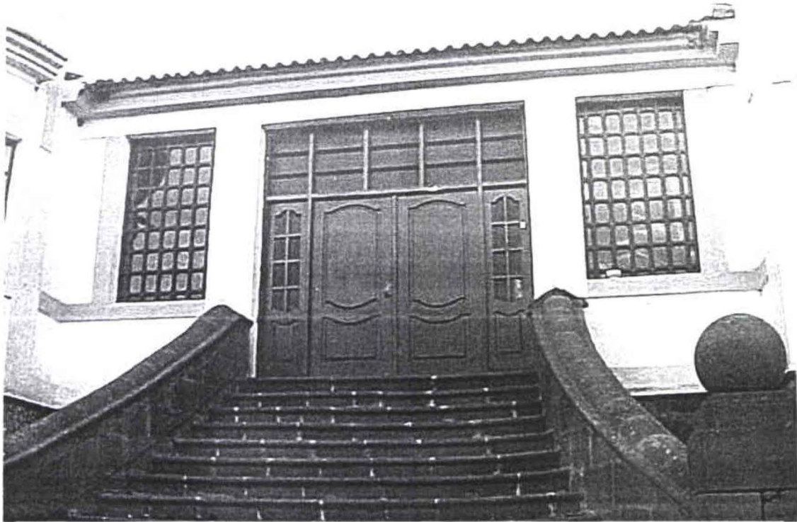
VISTA FRONTAL DE LA EDIFICACIÓN
