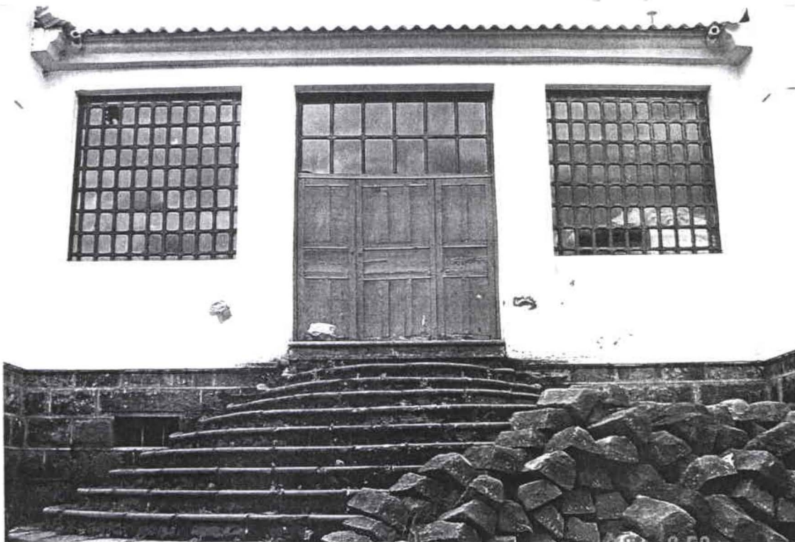
VISTA POSTERIOR DE LA EDIFICACIÓN
