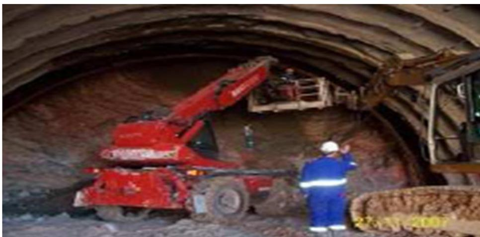
**Figura 44:** Cerchas metálicas tipo arco y tipo paraguas de micropilotes.
