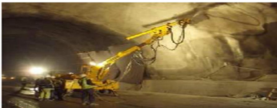
**Figura 43:** Hormigón proyectado mediante robot mecánico.
