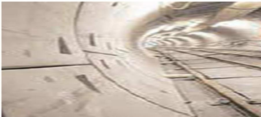
**Fig. 47:** Túnel revestido con paneles prefabricados de hormigón.
