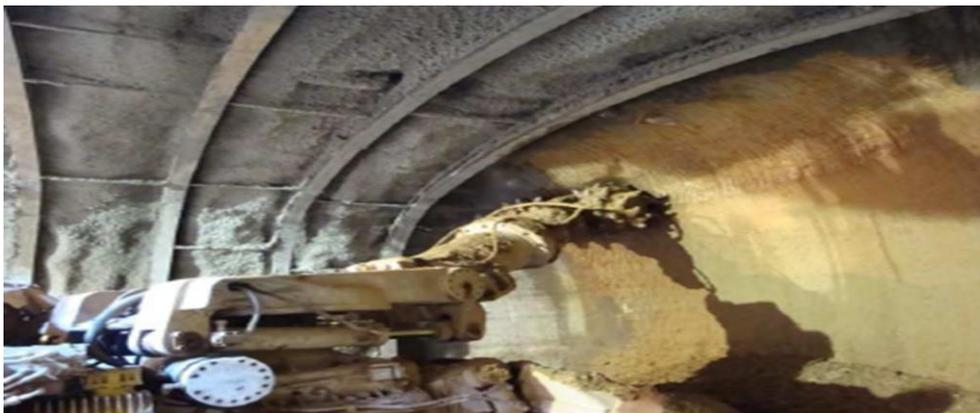
**Figura 37:** Excavación del túnel con rozadora.
