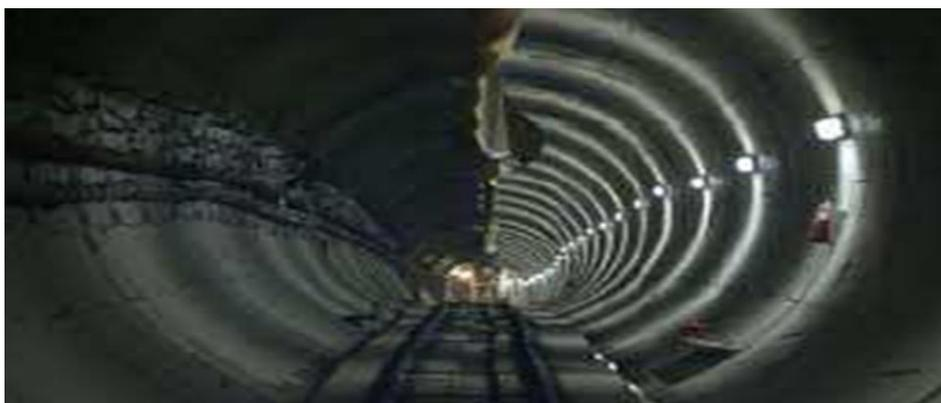
**Figura 46:** Túnel revestido de dovelas prefabricadas.
