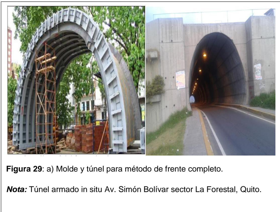
**Figura 29:** a) Molde y túnel para método de frente completo.
