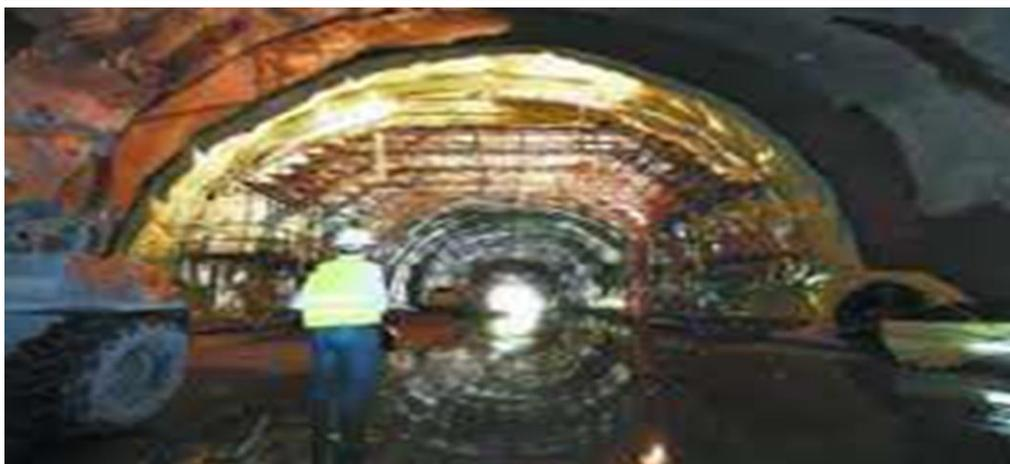
**Figura 45:** Carro de encofrado en un túnel de Guipúzcoa.
