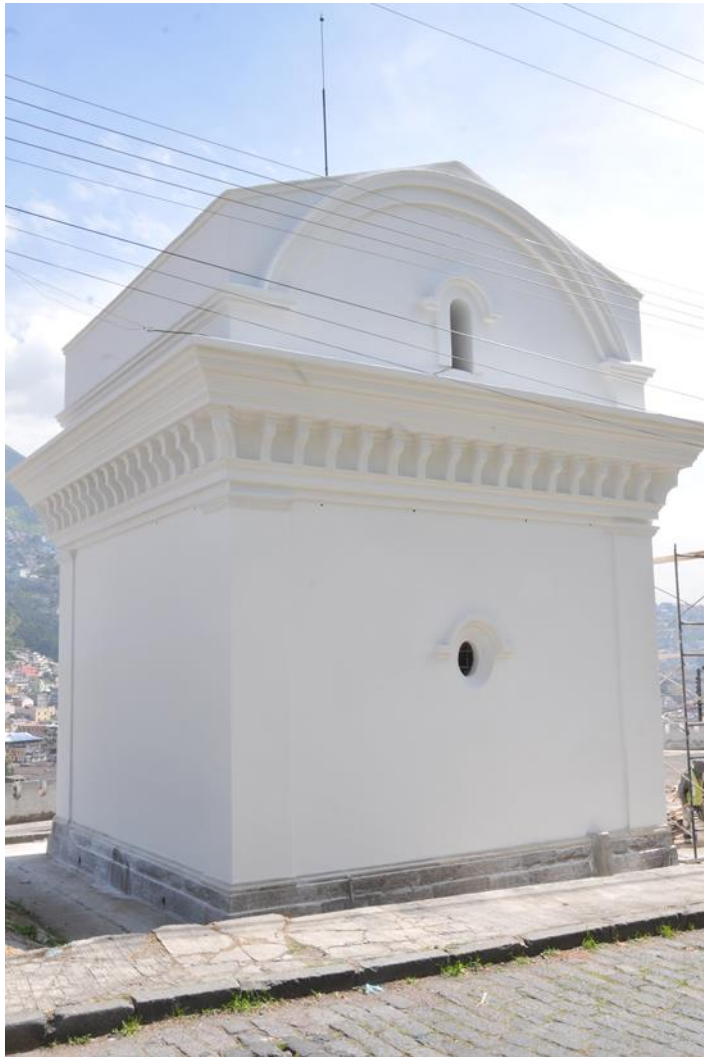
Figura 73. Lado derecho del cuarto que se utilizó Para guardar las municiones ( Quishpe, 2015)
