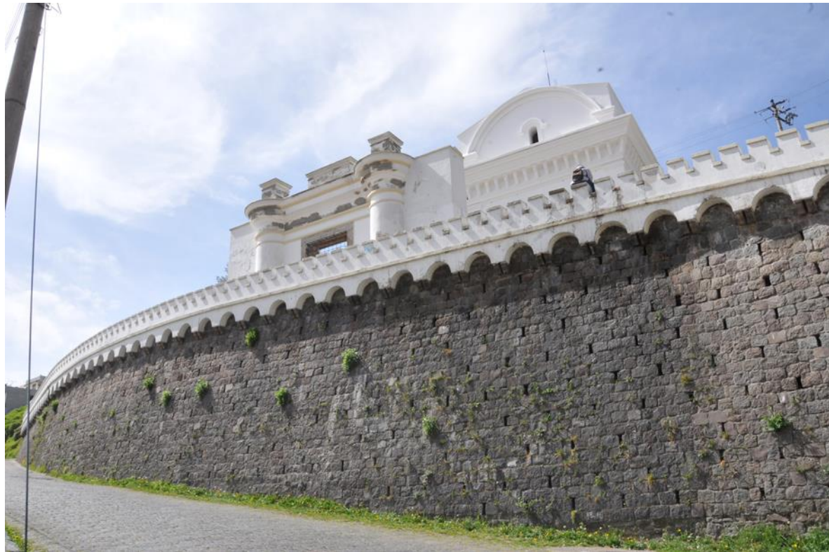
Figura 75. Parte inferior del fortín, este extremo se lo puede observar al lado este del ingreso hacia el Panecillo ( Quishpe, 2015)
