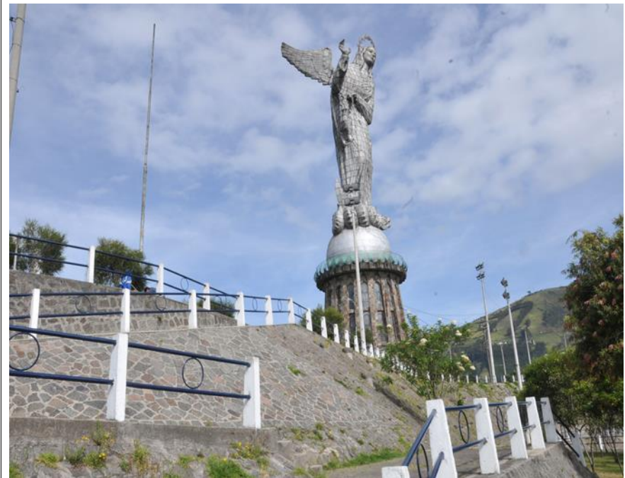
Figura 63. Lado inferior oeste del mirador ( Quishpe, 2015)
