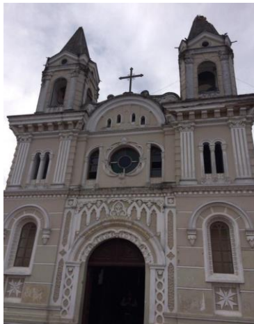
Vista iglesia de Calderón
