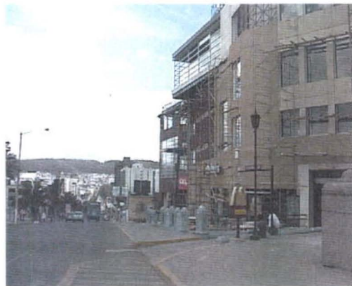
Vista de la edificación desde la Ave. Naciones Unidas
