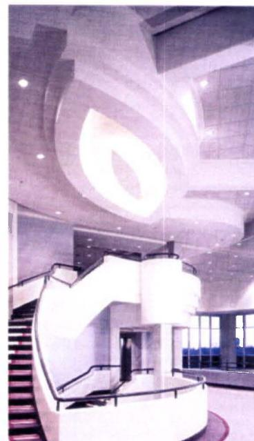
Diseño del cielo raso falso realizado en gypsum para lograr diferentes alturas y crear cenefas de iluminación indirecta para el area de circulación.
