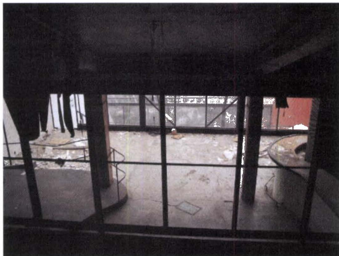
Vista desde la planta alta hacia la planta media.
