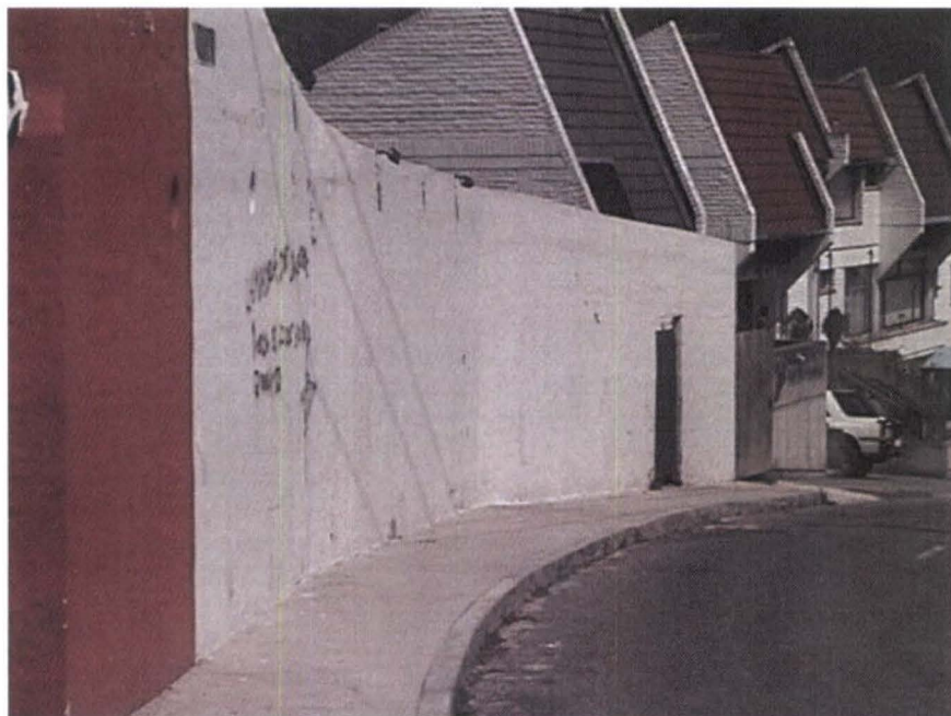
Fachada Frontal Tavú.
