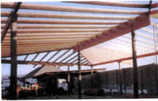
Estructura de madera
