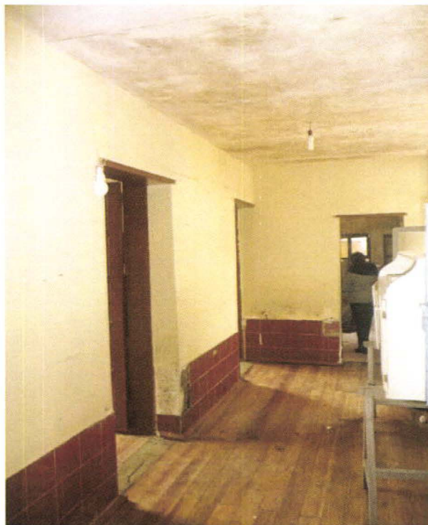
Figura 6. Interior Departamento Autoría.
