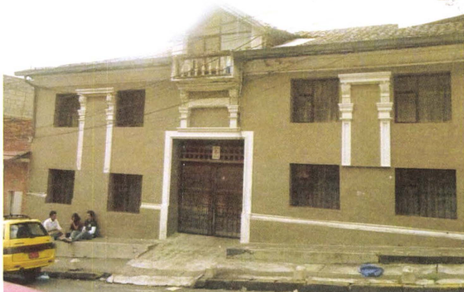
Figura 2. Fachada Frontal Autoría.
