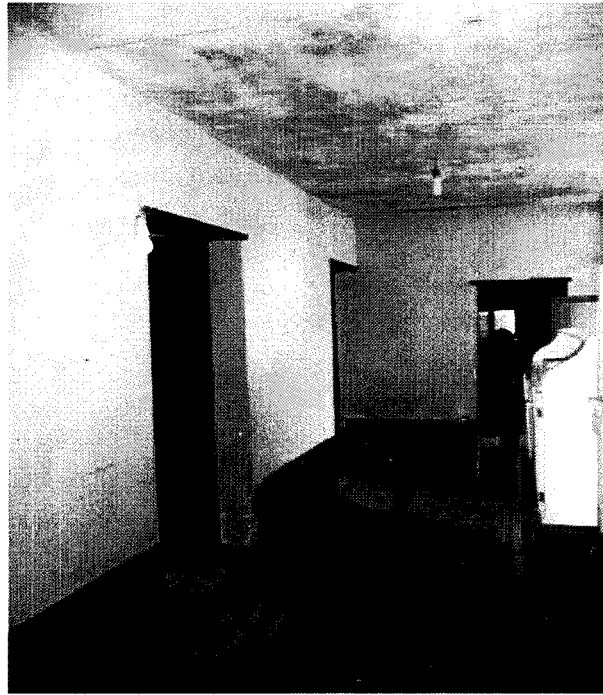
Figura 30. Interior Departamento Autoría.
