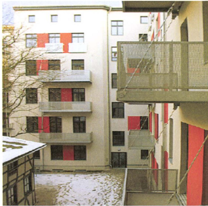
Figura 15. Patio Interior de la Edificación
