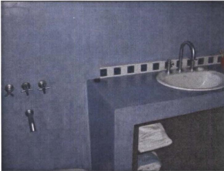
Son mayormente utilizados en **cocinas o baños** como vemos en la imagen, donde pueden combinarse con **mesadas o escaleras** realizadas también en **microcemento**. Otra interesante aplicación de este material es para **renovar suelos ya colocados**, donde pueden reemplazar al piso anterior sin necesidad de retirar éste último.
