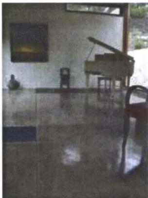
El microcemento alisado es un material cementicio pigmentado de 2 a 3 mm de espesor (contra los 5 cm de espesor del cemento alisado) que se puede colocar sobre cualquier superficie existente sin necesidad de levantar el piso actual. No genera escombros en obra y es de rápida colocación. Podemos decir que el microcemento alisado es básicamente una opción mejorada del cemento alisado.
