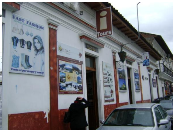
FACHADA CALLE GUAYAQUIL
