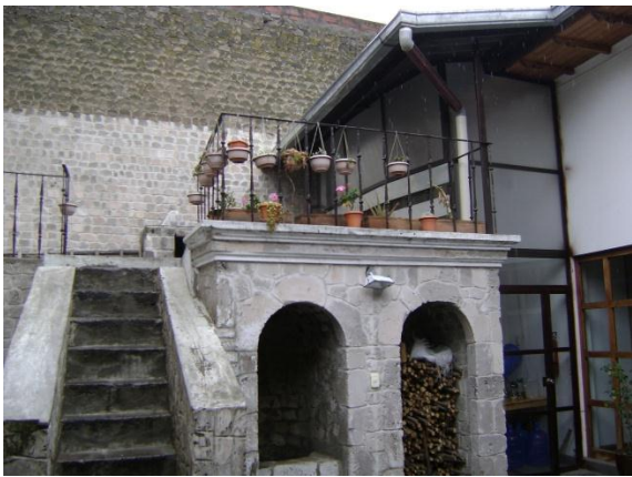
Pozo de Agua
